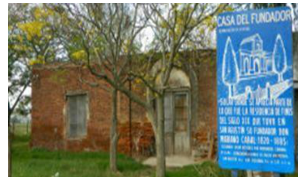
Casa del Fundador construida entre 1868 1871. (Circa)
